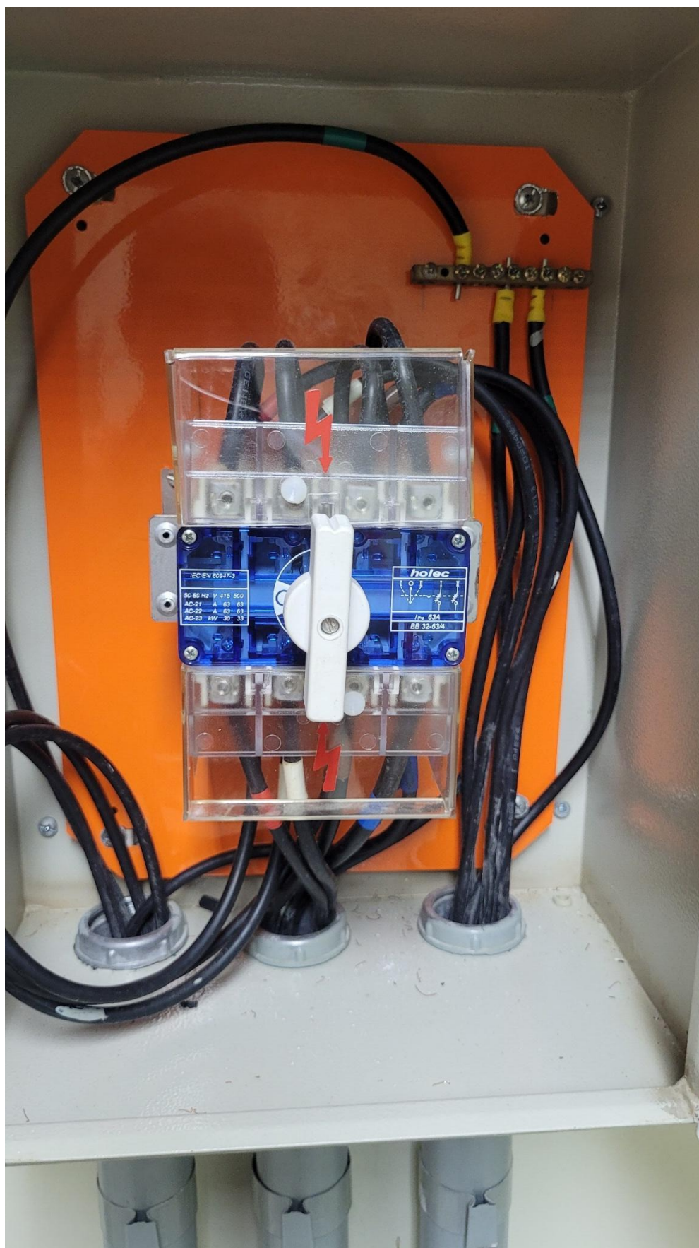
Foto 20 – Quadro elétrico CHAVE DESVIO do nobreak Dual (Circuito Y) da PRM Caruaru
