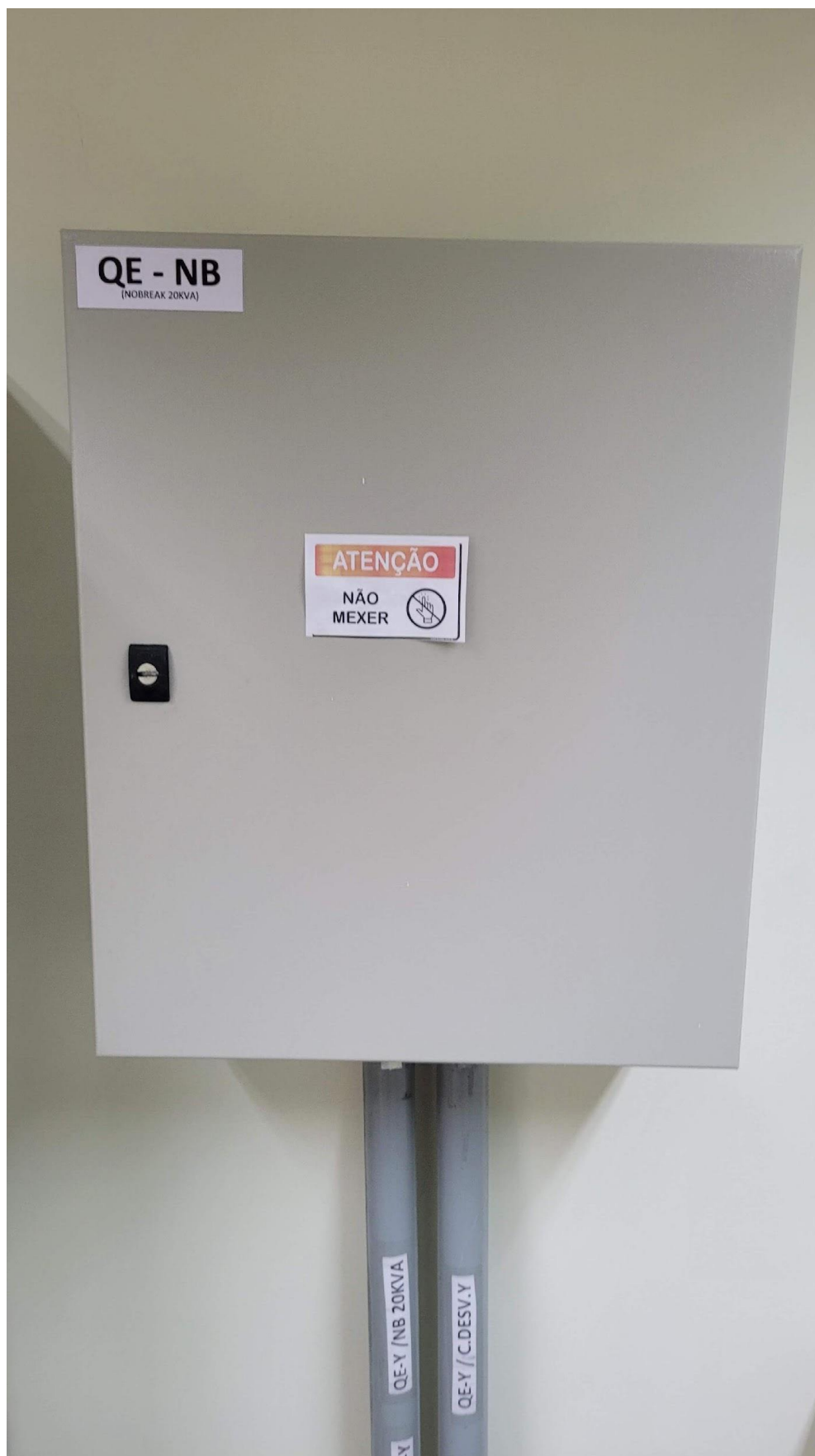
Foto 17 – Quadro elétrico QE-NB do nobreak Dual (Circuito Y) da PRM Caruaru
