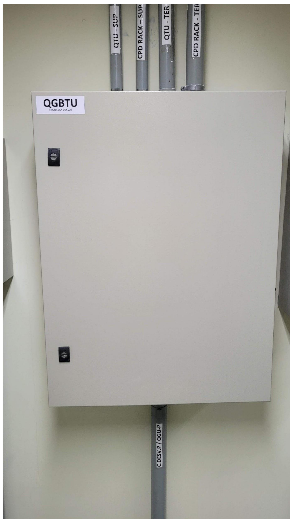
Foto 27 – Quadro elétrico QGBTU do nobreak Predial (Circuito X) da PRM Caruaru
