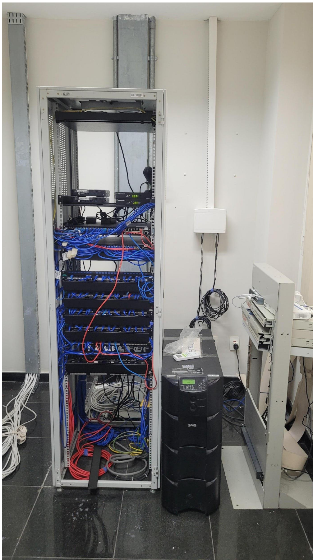
Foto 43 – Local da instalação do nobreak Dual (Circuito Y) da PRM Petrolina
