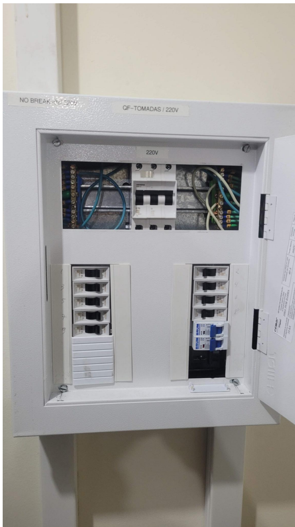
Foto 4 – Quadro elétrico de saída do nobreak 01 da PR-PE
