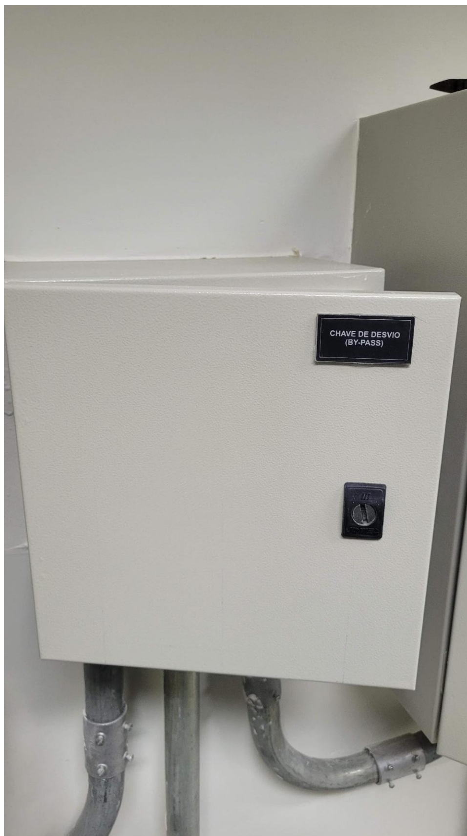
Foto 37 – Quadro elétrico CHAVE DE DESVIO do nobreak predial (Circuito X) da PRM Serra Talhada
