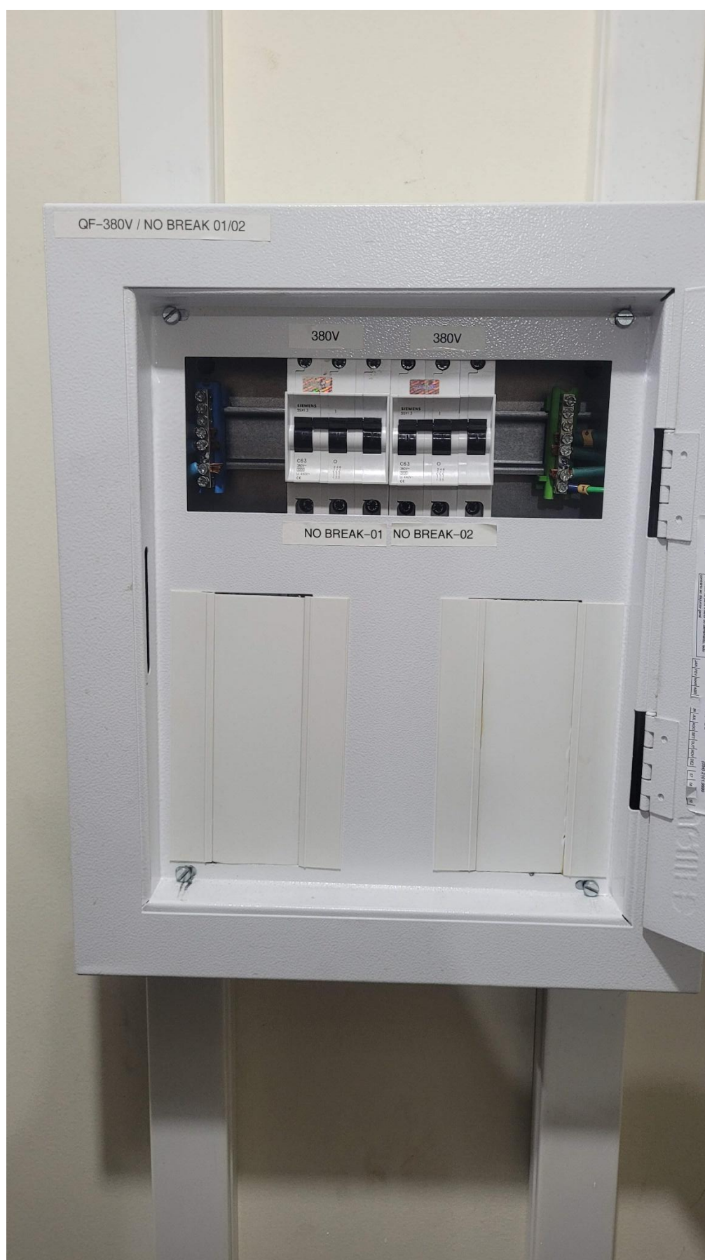
Foto 2 – Quadros elétricos de entrada/saída dos nobreaks da PR-PE
