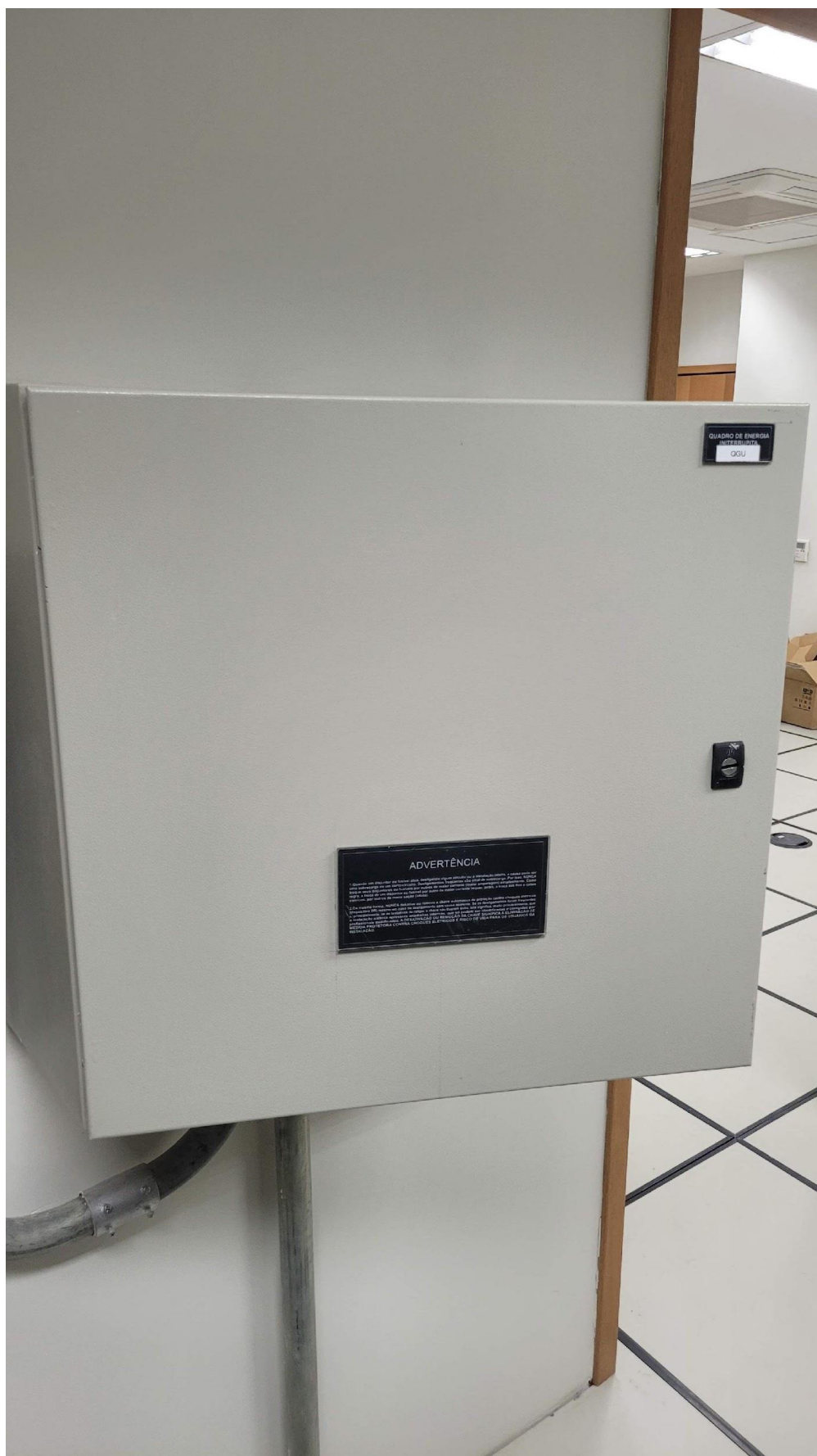
Foto 39 – Quadro elétrico QGU do nobreak predial (Circuito X) da PRM Serra Talhada
