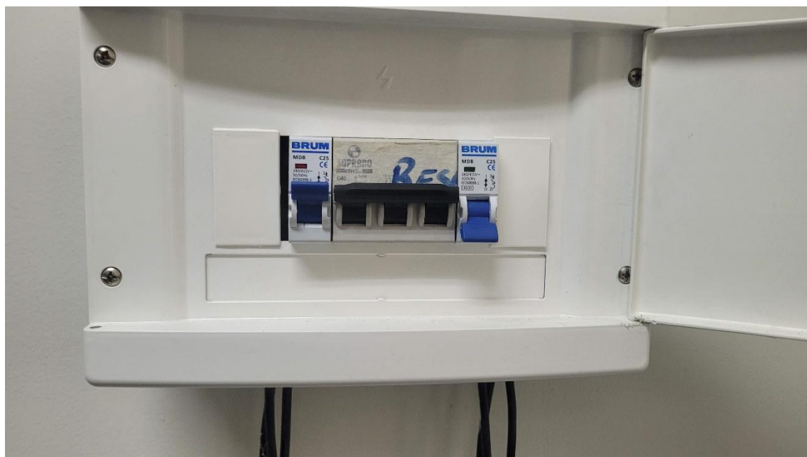
Foto 52 – Quadro elétrico de entrada do nobreak Dual (Circuito Y) da PRM Petrolina
