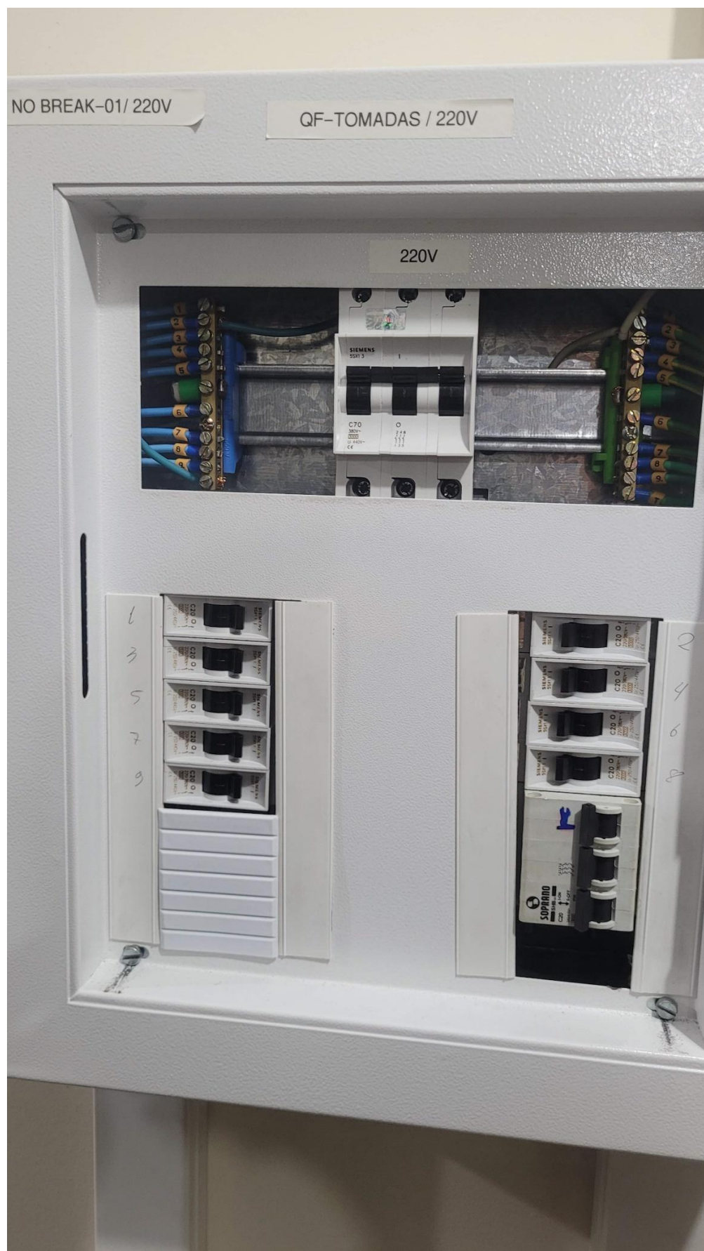
Foto 3 – Quadro elétrico de entrada dos nobreaks da PR-PE
