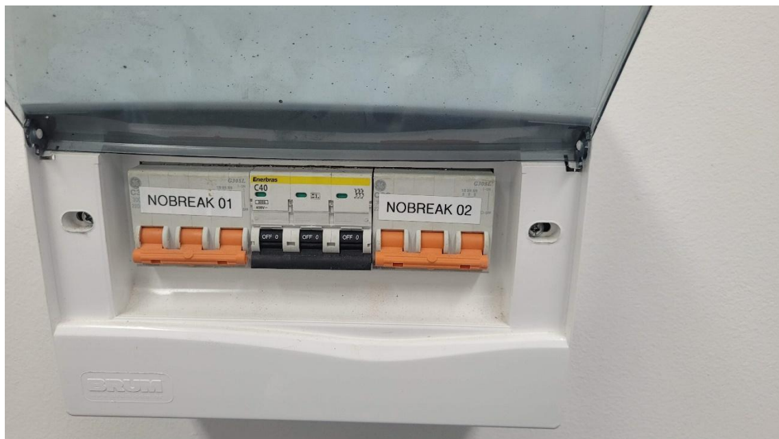
Foto 9 – Quadro elétrico de entrada/saída do nobreak da PRM Garanhuns
