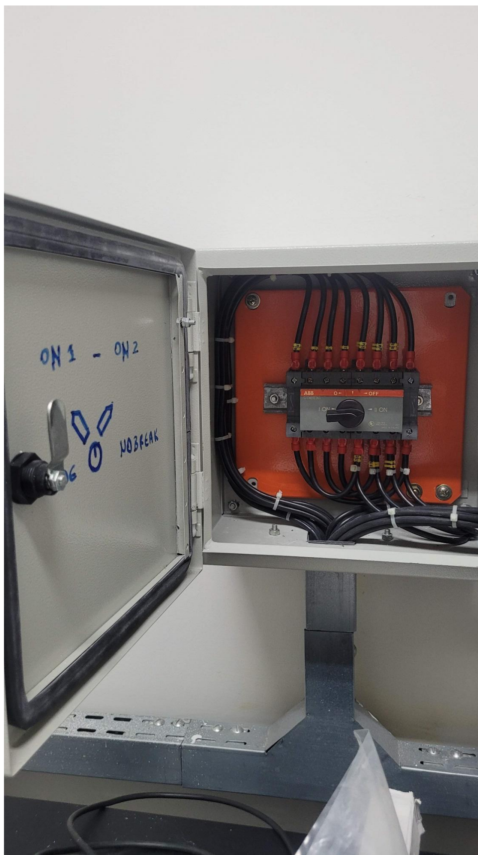
Foto 48 – Quadro elétrico CHAVE DESVIO do edifício da PRM Petrolina
