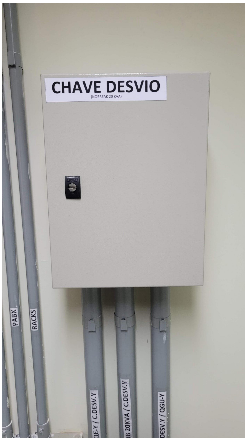
Foto 19 – Quadro elétrico CHAVE DESVIO do nobreak Dual (Circuito Y) da PRM Caruaru
