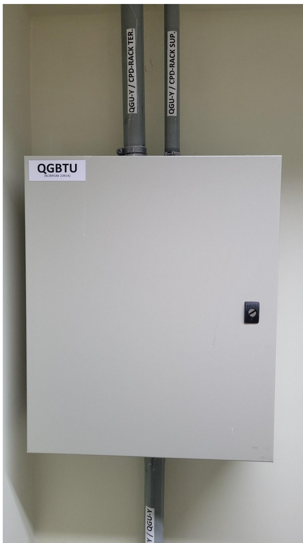
Foto 21 – Quadro elétrico QGBTU do nobreak Dual (Circuito Y) da PRM Caruaru
