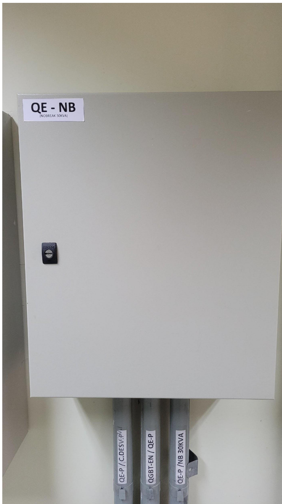
Foto 23 – Quadro elétrico QE-NB do nobreak Predial (Circuito X) da PRM Caruaru
