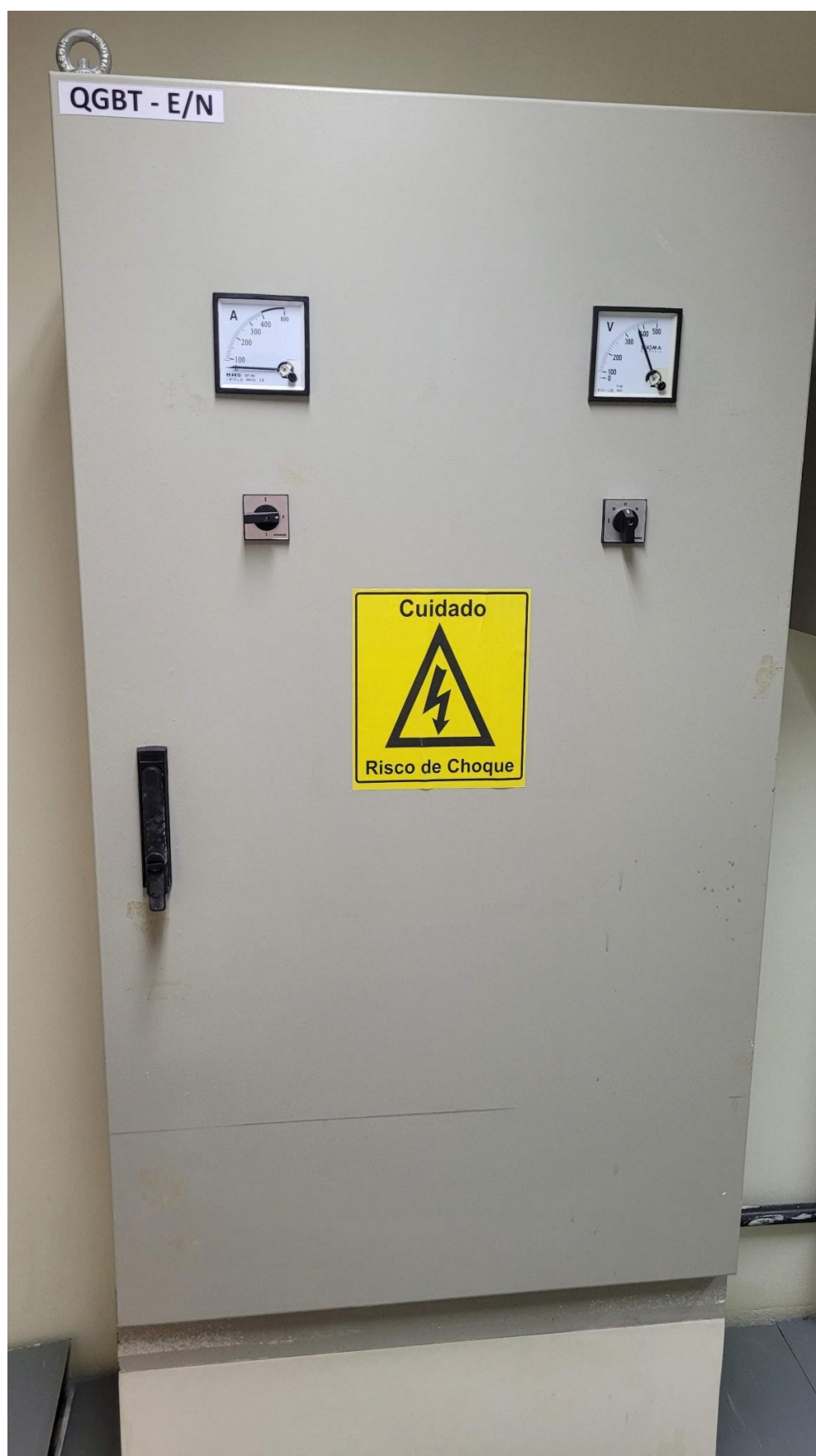
Foto 15 – Quadro elétrico QGBT do edifício da PRM Caruaru
