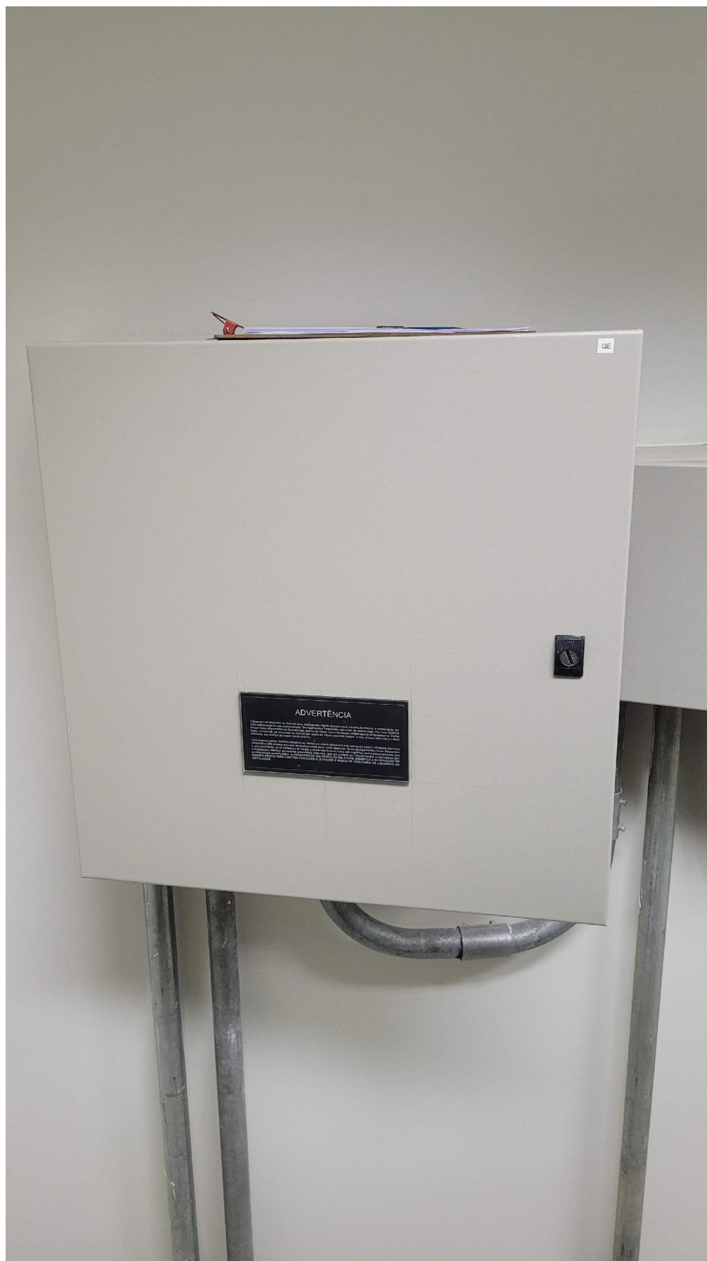
Foto 35 – Quadro elétrico QE do nobreak predial (Circuito X) da PRM Serra Talhada
